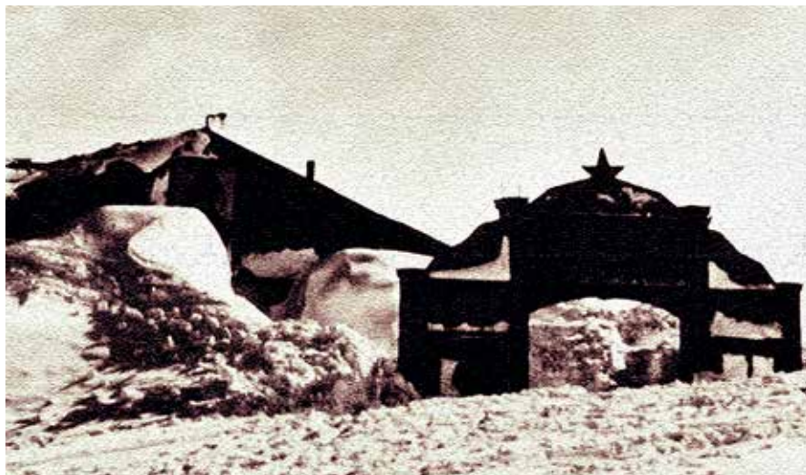
Контора укрупненного Шугуровского нефтепромысла, 1945 год
