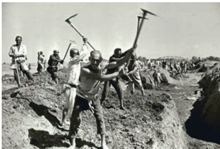
На строительстве Большого Ферганского канала, 1939 год
