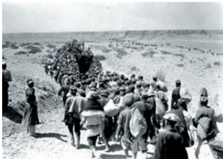
Выход колхозников на строительство Большого Ферганского канала, Таджикская ССР, 1939 год
