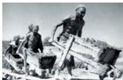
На строительстве Большого Ферганского канала
